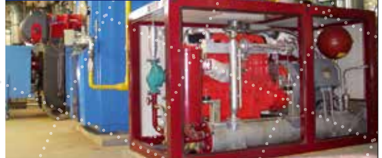
Heizzentrale mit BHKW
