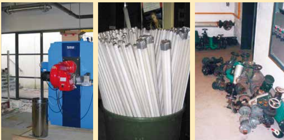
Es gibt viel zu tun: Wie hier bei den Solar&Spar-Projekten können auch bundesweit viele Schulen durch Austausch ineffizienter Heizkessel, Beleuchtung und Umwälzpumpen wirtschaftlich energetisch saniert werden.
