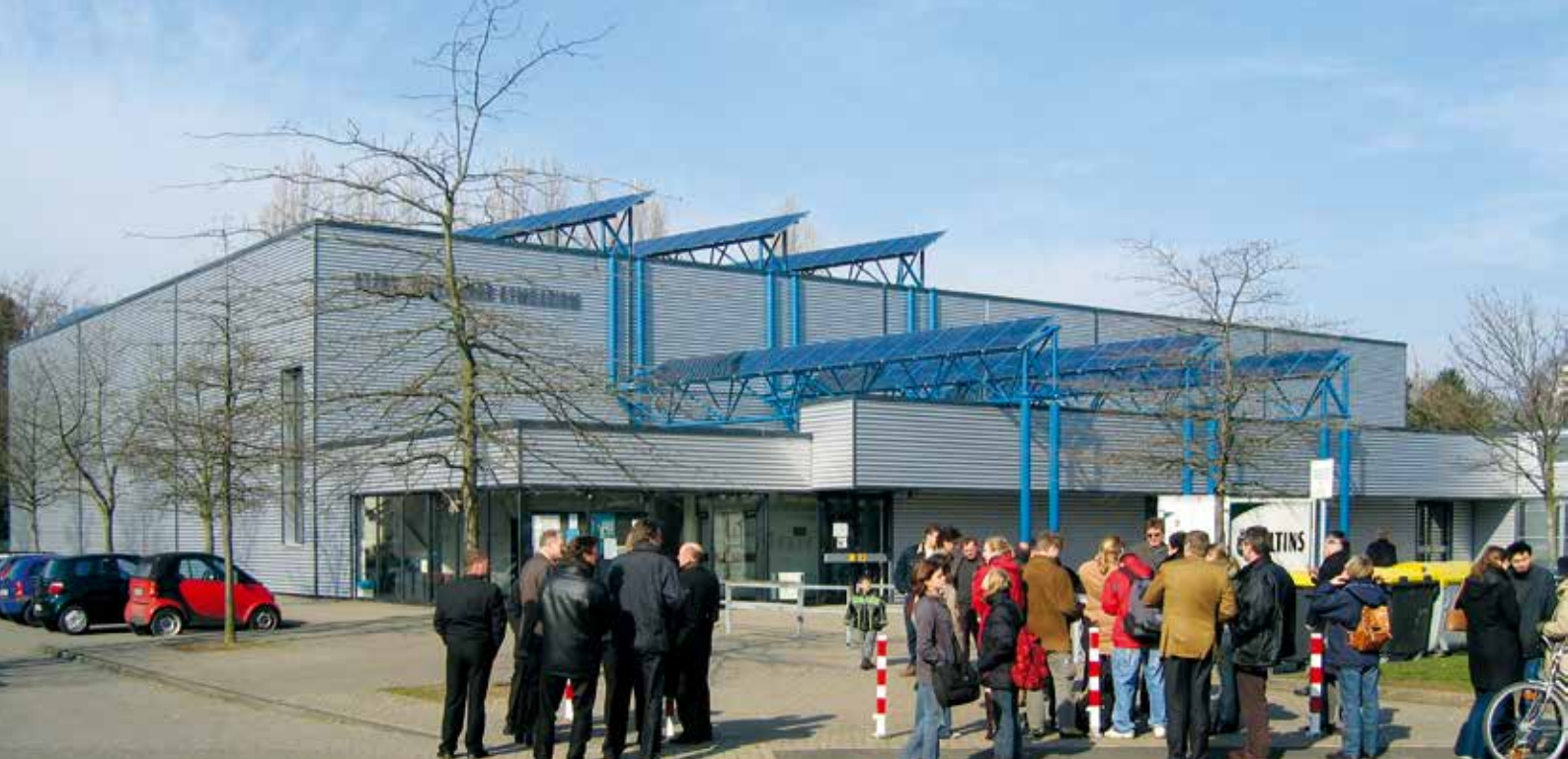
Klima-Engagement sichtbar gemacht: Photovoltaik-Anlage auf dem Dach des Willibrod-Gymnasiums in Emmerich
