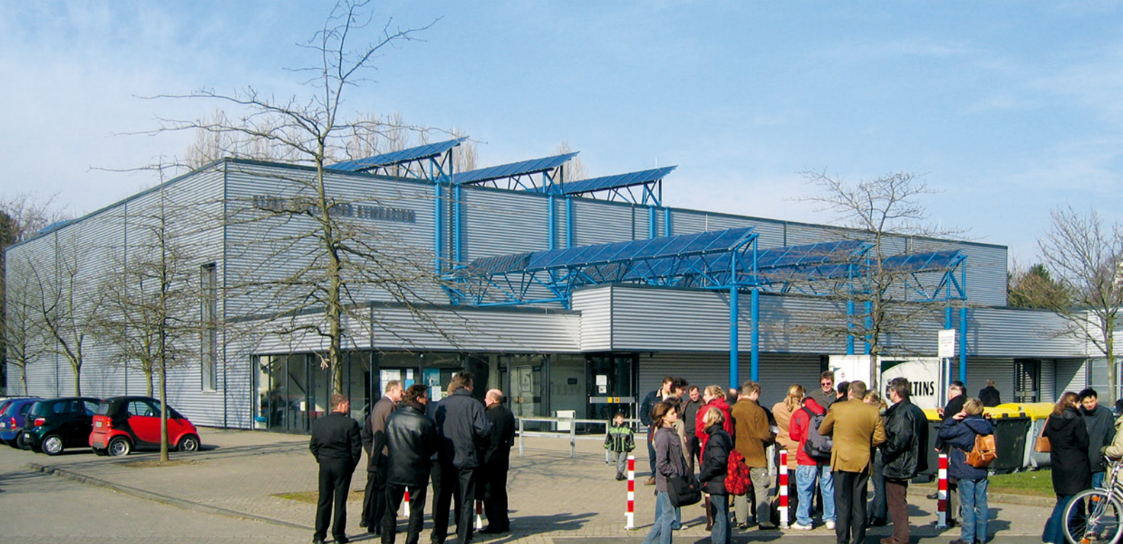
L'engagement climatique rendu visible: installation photovoltaïque sur le toit du Willibrord Gymnasium à Emmerich
